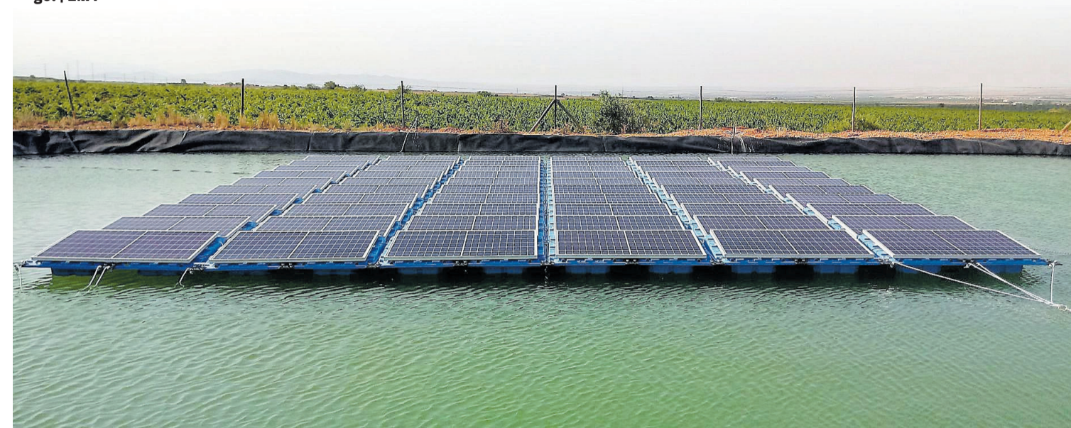
Placas fotovoltaicas flotantes en una balsa de riego. | EMV
